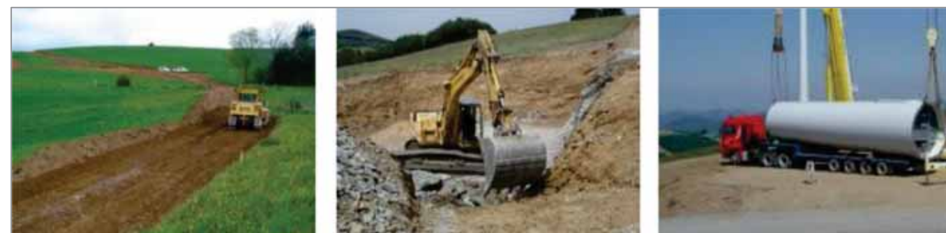
Photographie 31 : Illustration d'un chantier éolien
