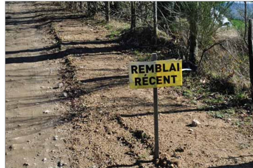
Photographie 28 : Exemple de remblai des tranchées électriques le long d'une piste
