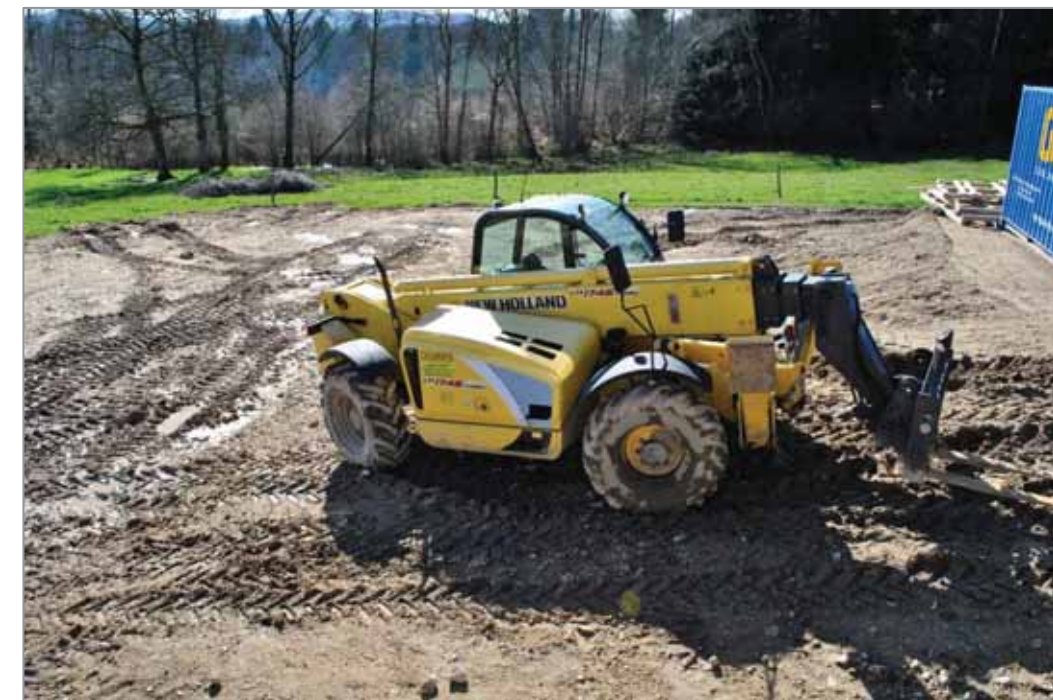
Photographie 29 : Exemple de tassement et d'ornières créés par les engins de chantier
